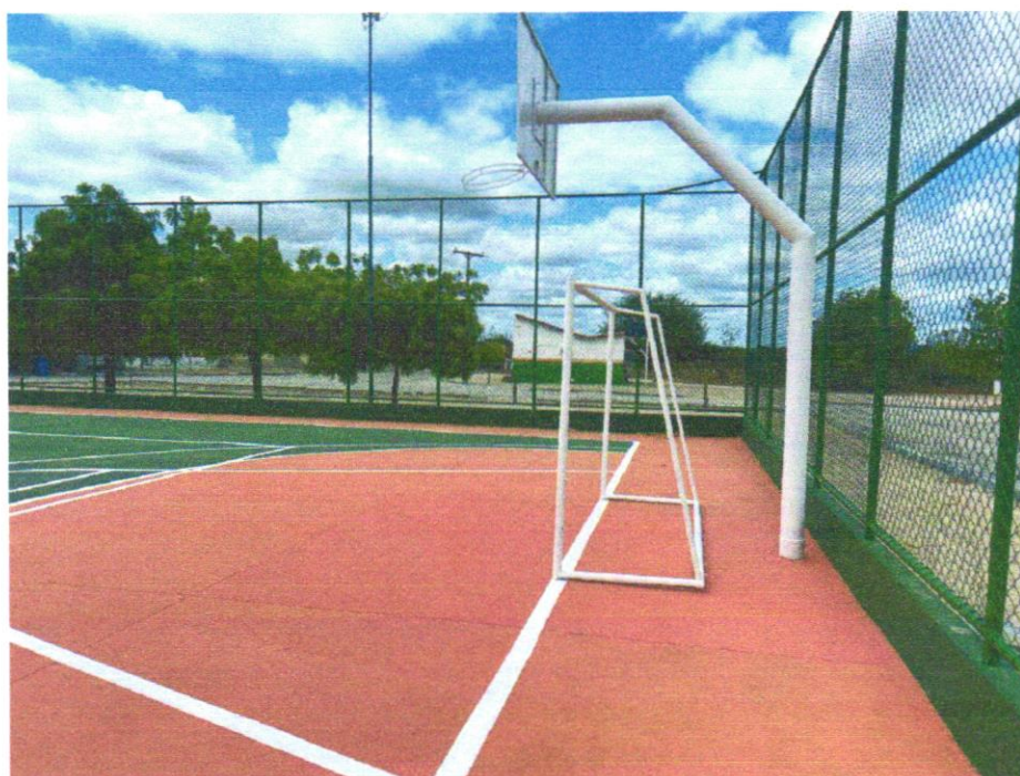
Foto 04- Estrutura metálica fixa, p/ tabela em aço com aro e cesta p/ basquete, padrão oficial, em tubo galvanizado d=5" - instalada
