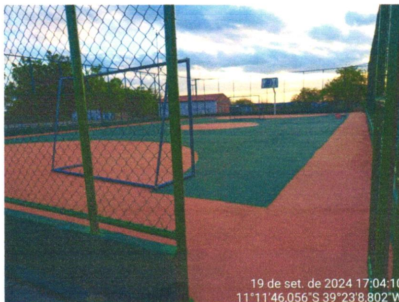
Foto 06 - PINTURA DE PISO COM TINTA ACRÍLICA, APLICAÇÃO MANUAL, 2 DEMÃOS, INCLUSO FUNDO PREPARADOR. AF_05/2021
