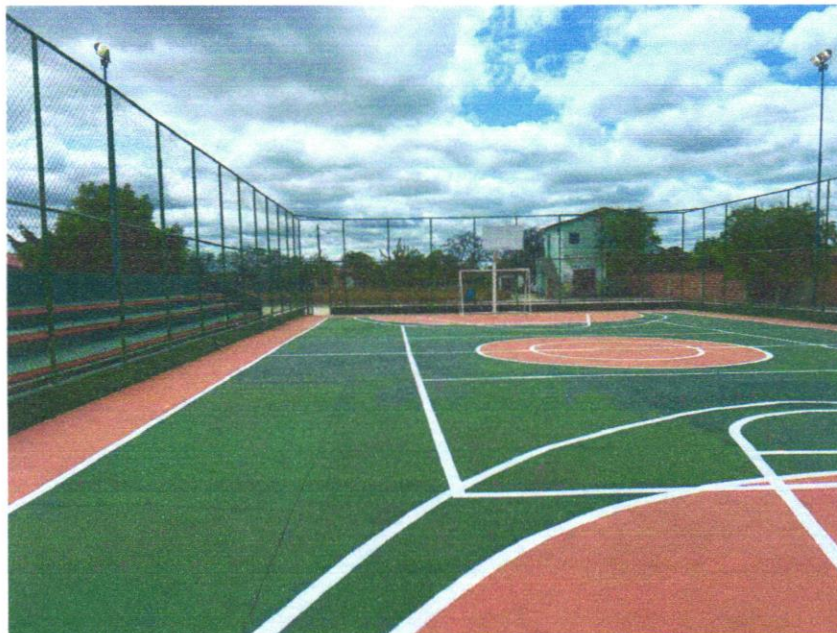
Foto 03 – Estrutura metálica fixa, p/ tabela em aço com aro e cesta p/ basquete, padrão oficial, em tubo galvanizado d=5" - instalada
